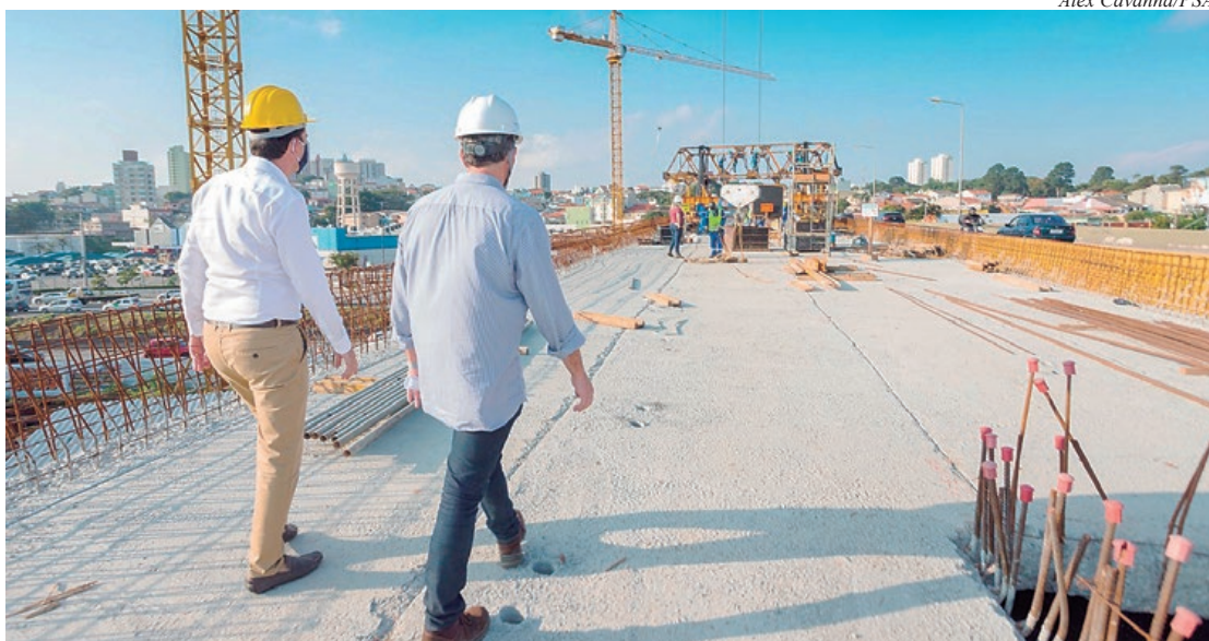
Prefeito Paulo Serra (esquerda) realizou vistoria no canteiro de obras
