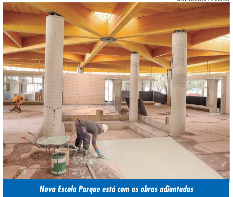
Prefeito Auricchio vistoriou obras da nova escola na Rua Tibagi
