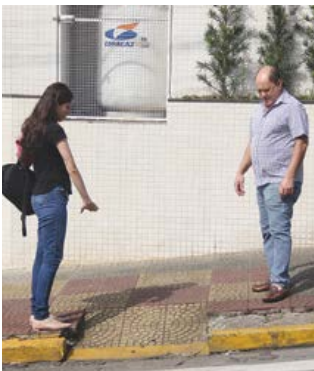
Verificando estado das calçadas
