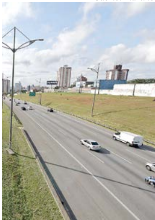
Ecovias realiza obras na rodovia
