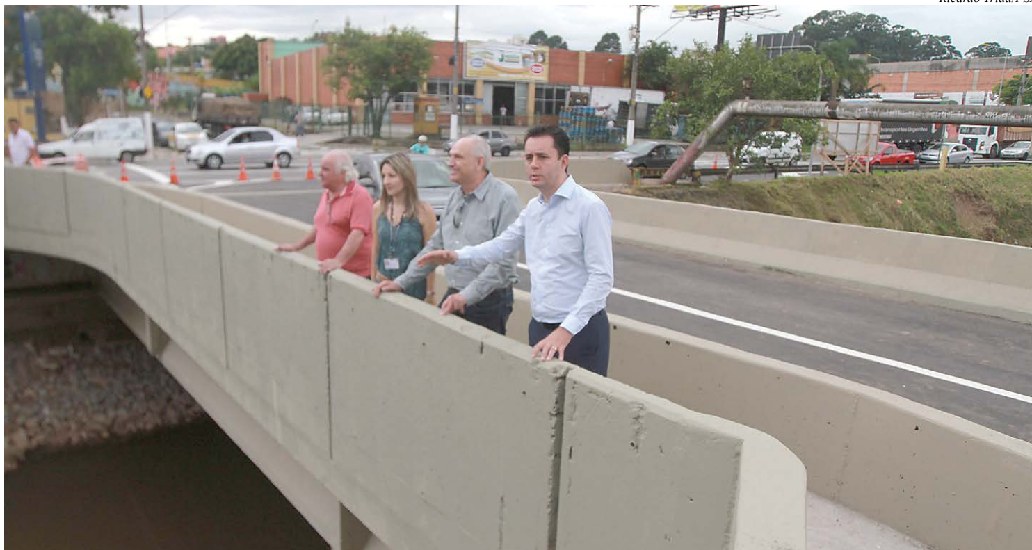
Prefeito Paulo Serra esteve acompanhando a reabertura da ponte em Santo André
