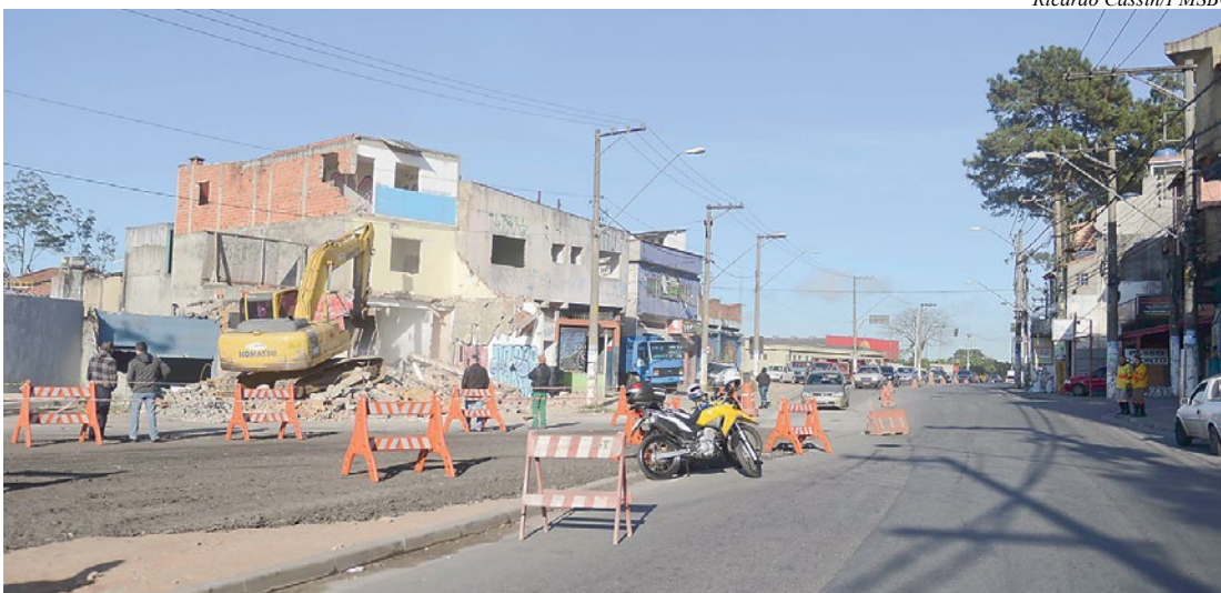
Prefeitura remove imóveis para acelerar as obras
