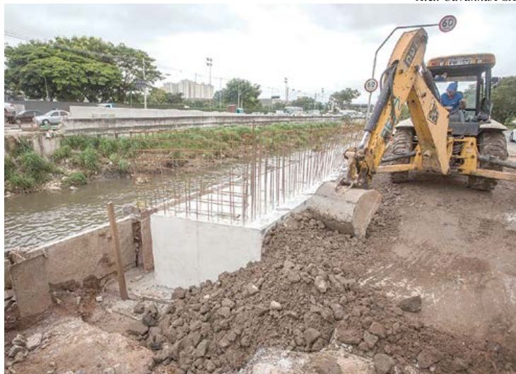
Avenida dos Estados segue em obras
