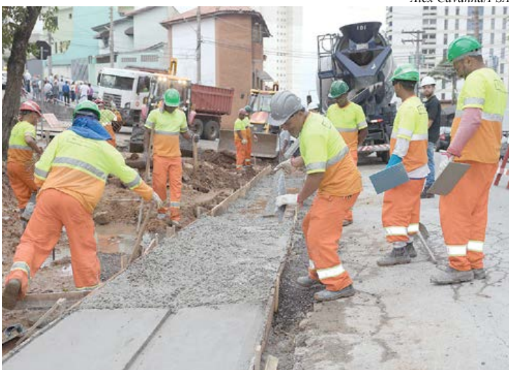
Intervenções tiveram início na rua Espanha, no Parque das Nações
