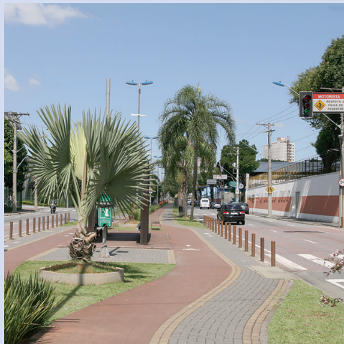
Obras devem começar em setembro
