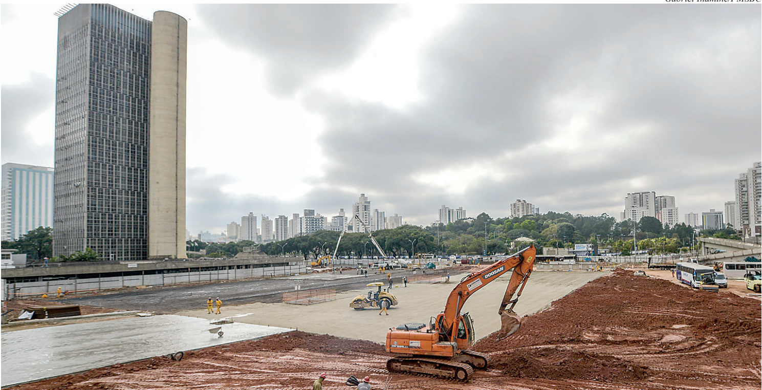
Etapas de execução da obra é a concretagem e acabamento com a parte de cobertura de todo o reservatório já concluído
