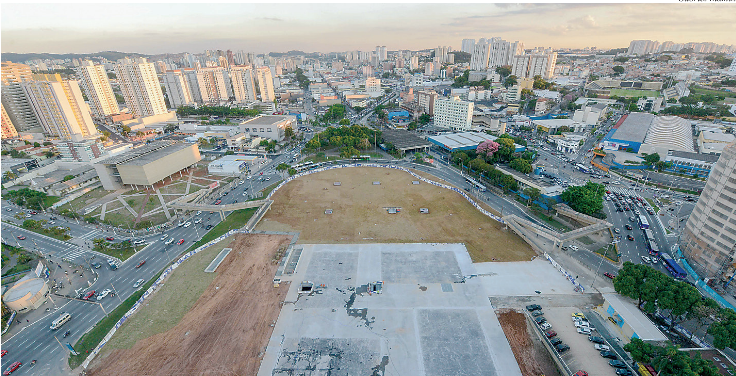
Reservatório tem capacidade de armazenamento de 220 milhões de litros de água
