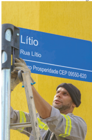
Nova placa sendo instalada
