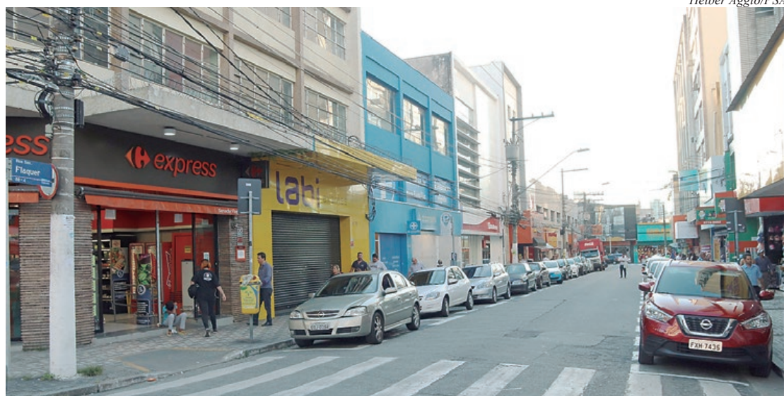
Rua Senador Fláquer está interditada parcialmente para as obras
