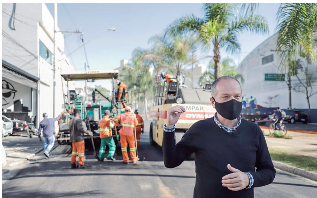
Prefeito Tite Campanella no recapeamento asfáltico da Avenida Presidente Kennedy
